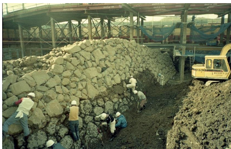
旧東急ホテル建設の際に発見された石垣
